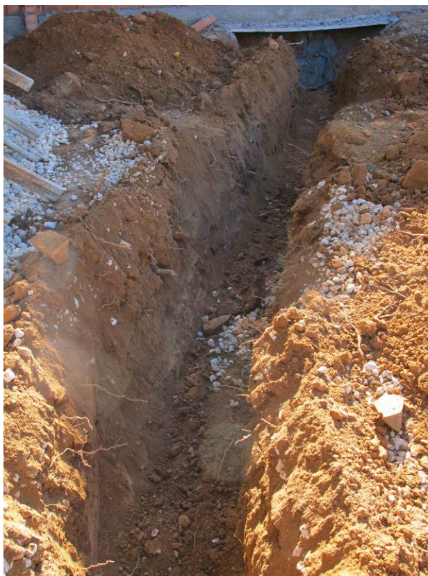
Foto 66: Tram final amb obertura C
