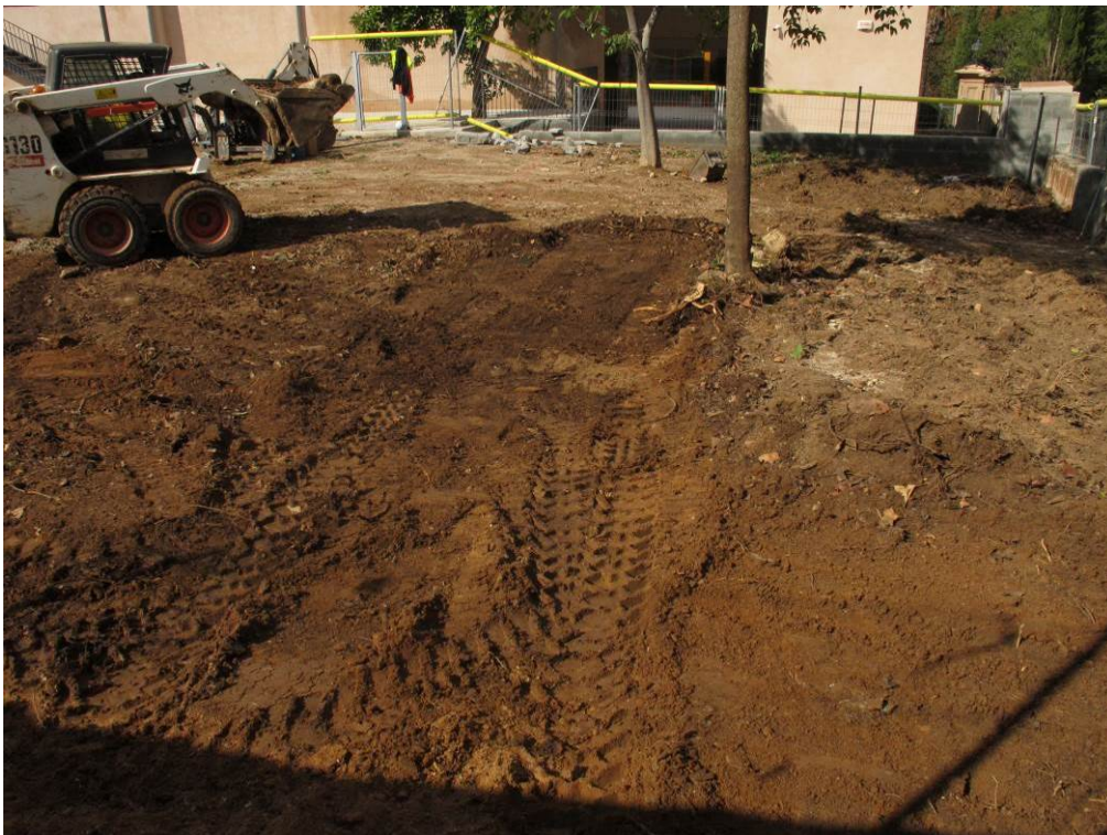
Foto 6: Rampa direcció N
