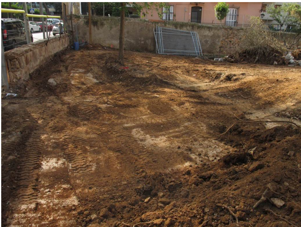
Foto 13: Vista general de la rampa. Direcció S
