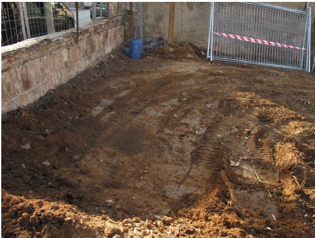
Foto 12: Vista general de la rampa. Direcció S
