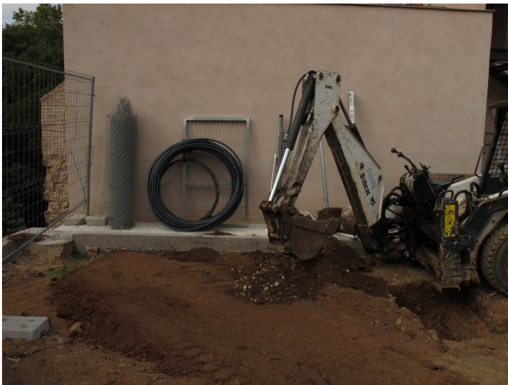
Foto 59: Inicial tasques de rebaix al sector NO
