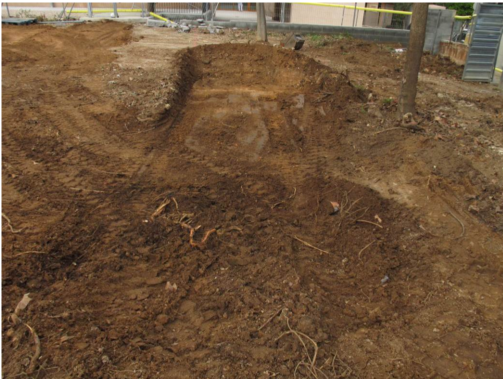
Foto 8: Rampa direcció N
