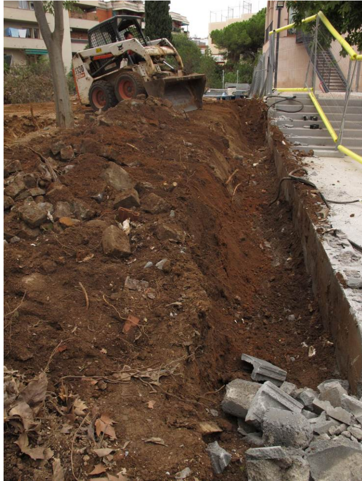
Foto 11: Tasques de rebaix a la zona adjacent a l'edifici
