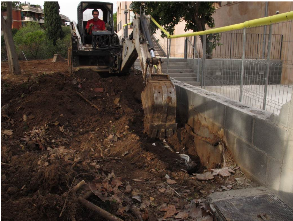
Foto 10: . Tasques de rebaix a la zona adjacent a l'edifici
