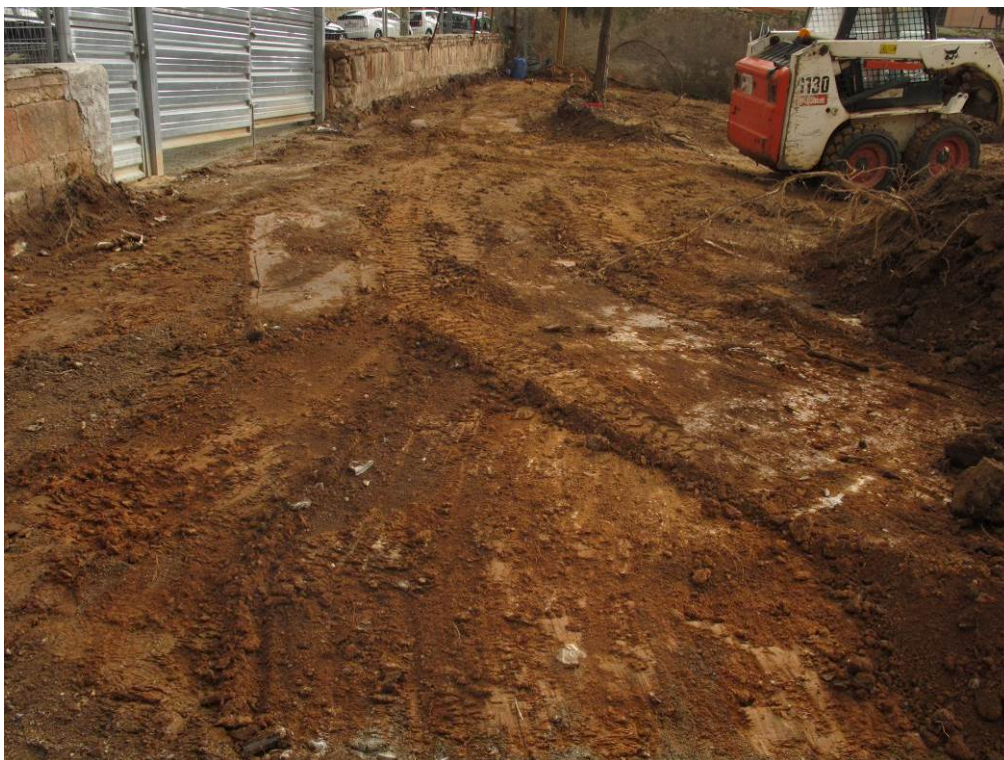
Foto 14: Vista general de la rampa. Direcció S
